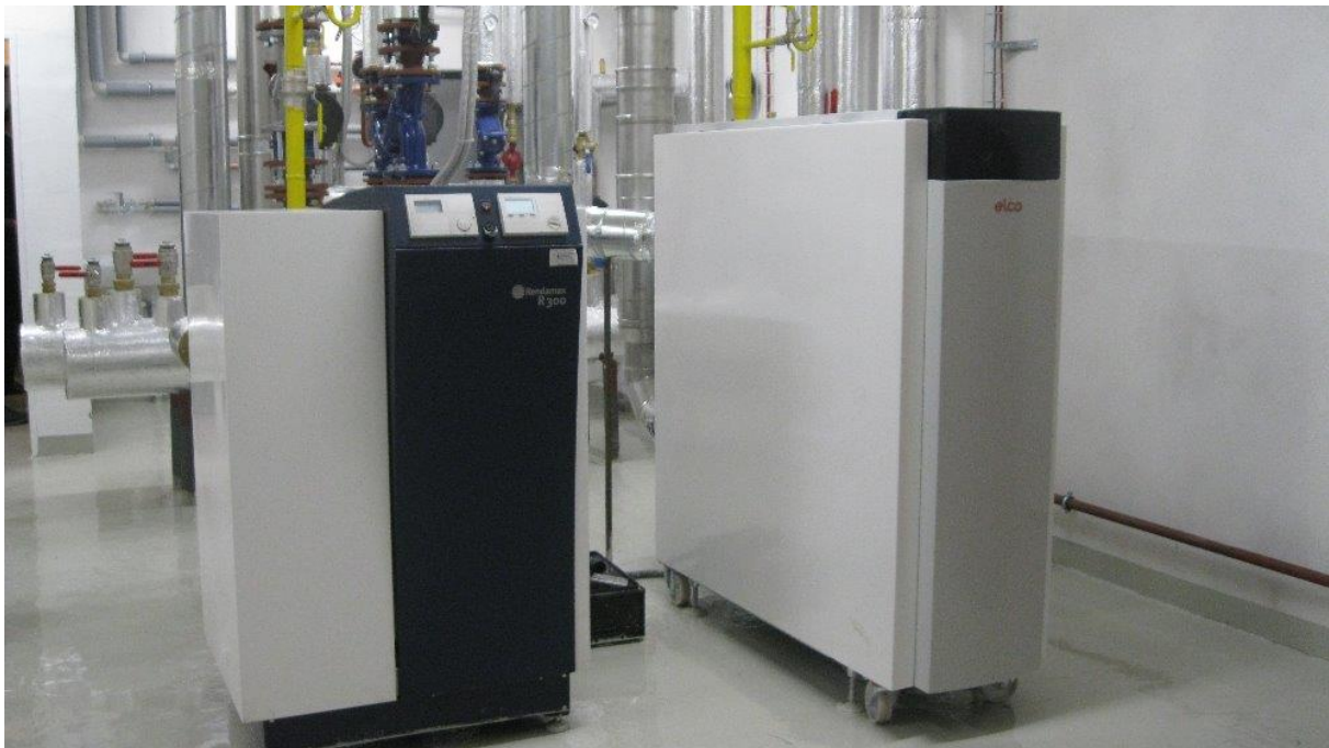
Závodiště Velká Chuchle, Praha 5 - rekonstrukce plynové kotelny/výstavba nového zdroje, financováno z investičních prostředků společnosti Prometheus, a.s., velikost zdroje 464 kW, realizace říjen 2017
