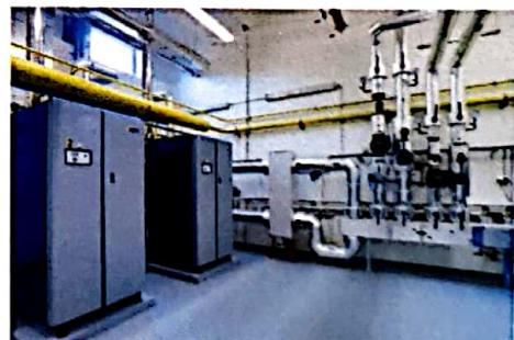
2. **Za hydraulickým oddělením** kotlové a sekundární části bude instalované okruhy ÚT s řízeným směšováním dle venkovní teploty a okruh nabíjení zásobníku TUV s deskovým výměníkem.
