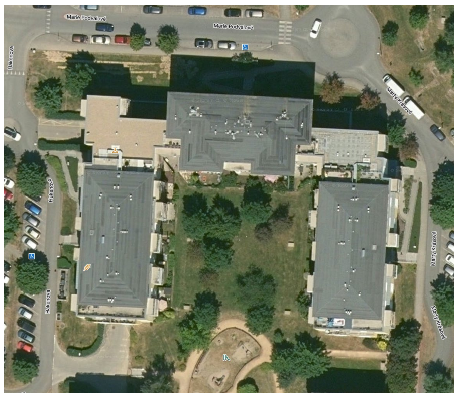
Obrázek 2 – Satelitní pohled na řešené střechy – Hakenova
