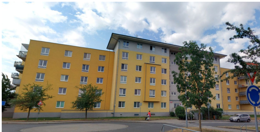
Obrázek 1 - Pohled na Bytový komplex Hakenova
